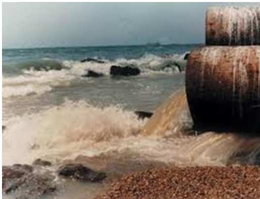
Figura 3. 1. Descarga de agua residual al mar.
