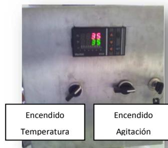
**Ilustración 2.-** Panel de control de los biodigestores (pantalla de control de temperatura °C, encendido y apagado de temperatura y agitación).
