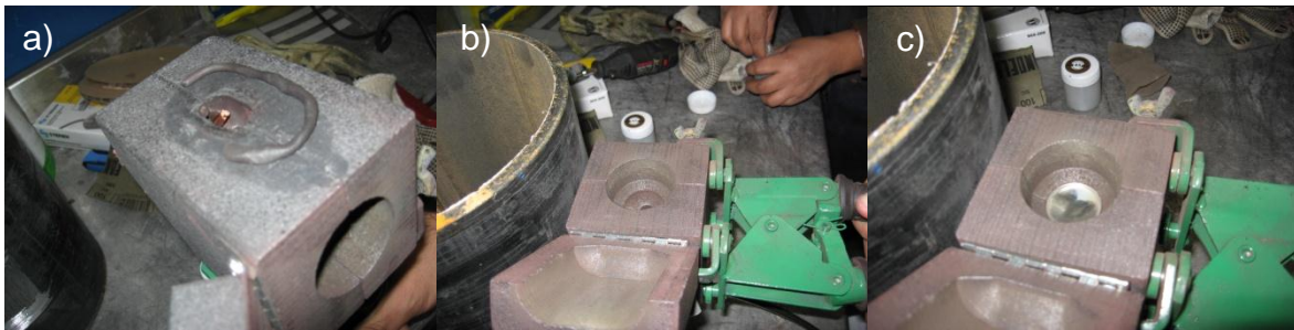
Figura 15. a) Cable de cobre, b) Pistola en la zona del ducto a soldar, c) Plato donde se coloca la carga.
