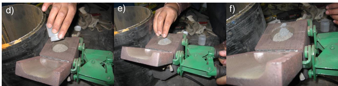
Figura 15. d) Carga para soldar, e) Pólvora, f) Carga preparada para soldar.
