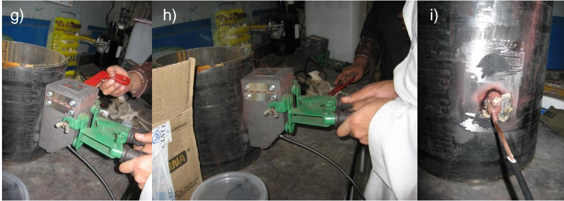
Figura 15. g) Ignición de la carga, h) Proceso de soldadura, i) Ducto soldado.
