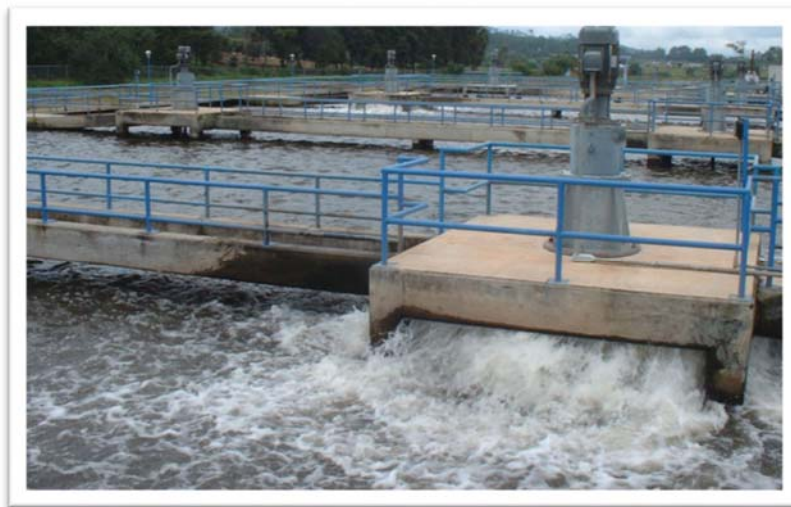
Figura 1. Planta de tratamiento de aguas residuales.
