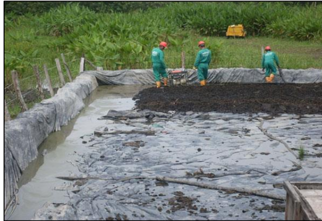
Figura 5. Imagen fotográfica de las actividades que se desarrollan durante el acondicionamiento del sitio contaminando para desarrollar un tratamiento biológico de suelos [23].
